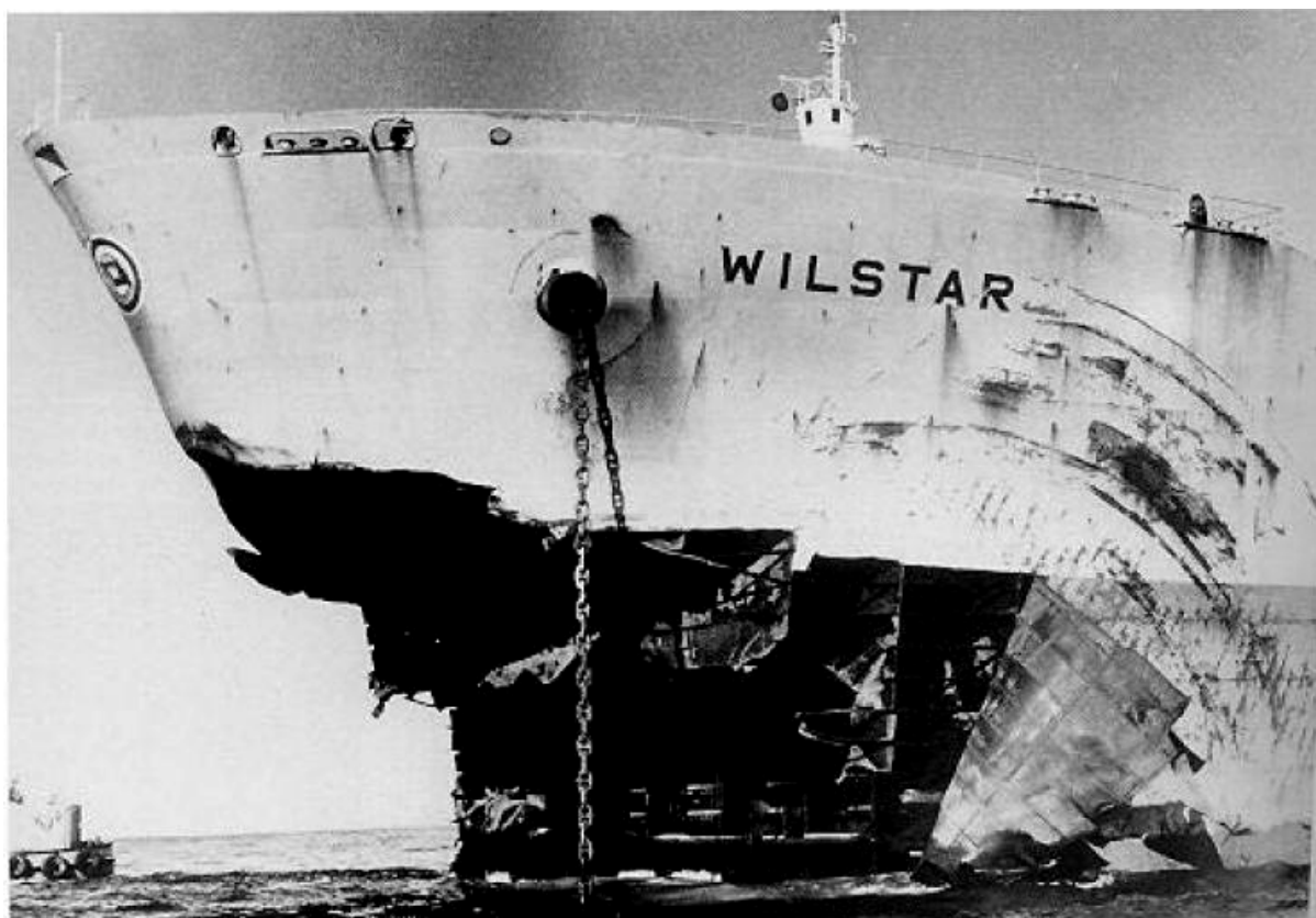
Рисунок 3.45 – Пример разрушений от удара волны
