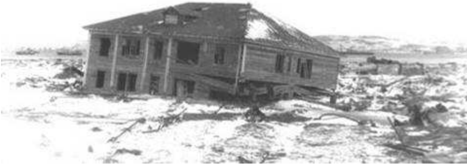
Рис. 1. Двухэтажный дом в Северо-Курильске, сорванный цунами 1952 года с фундамента и перенесенный на другое место (Kaistrenko and Sedaeva, 2001)
